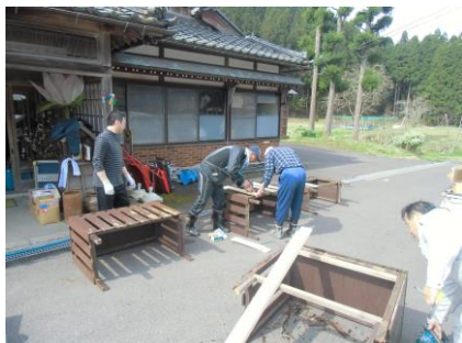
エアコン室外機塗り替え
